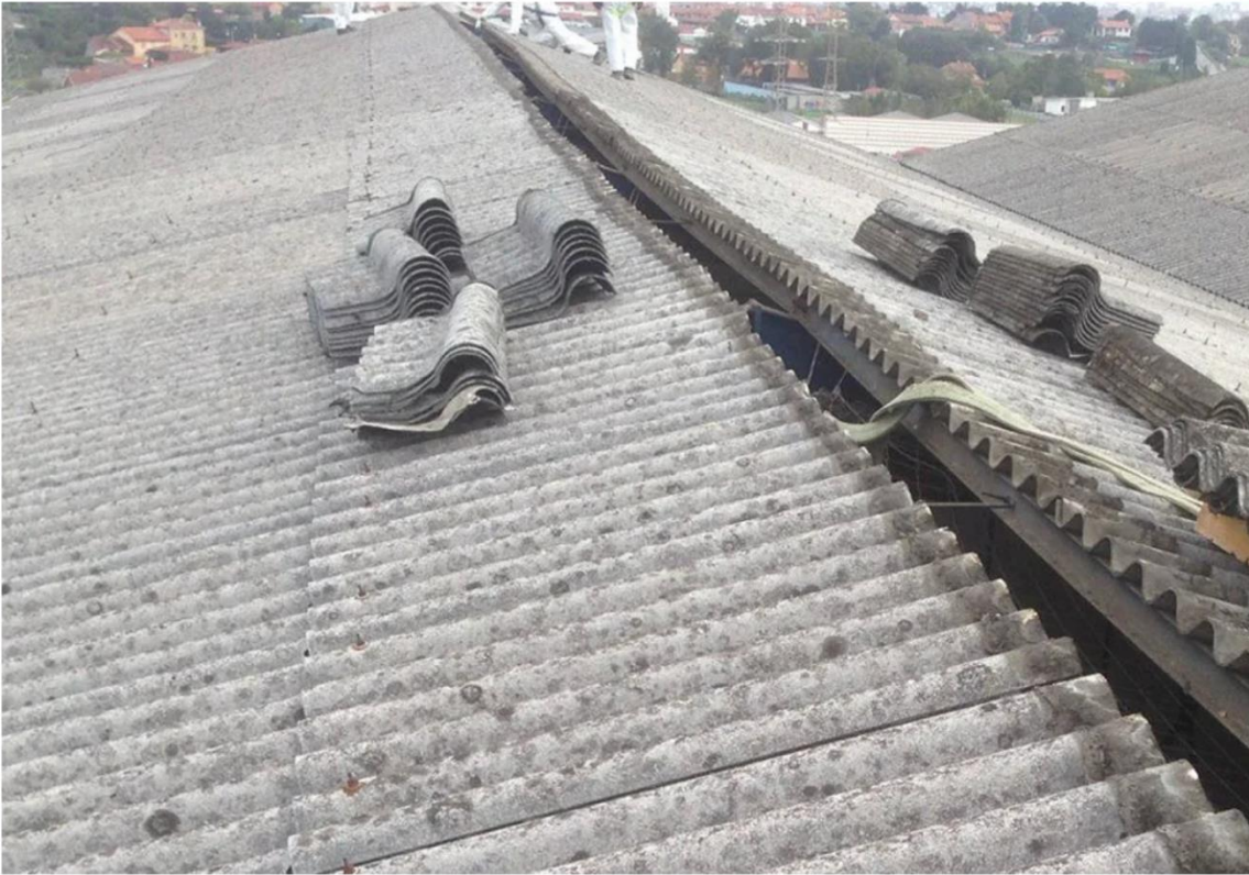
Trabajos de retirada de amianto de una cubierta | Imagen de archivo
