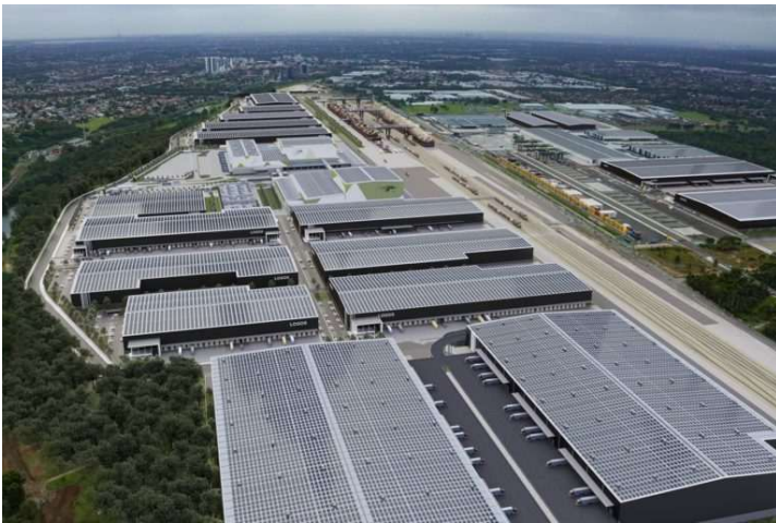
Nave de MLP en Sídney, Australia
