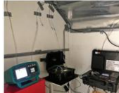
Figura 9. Sin confinamiento y presión negativa.
