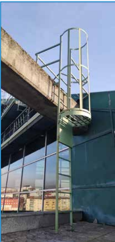
Se vas usar unha escala fixa valora a necesidade de facer uso dun sistema de protección anticaídas.
