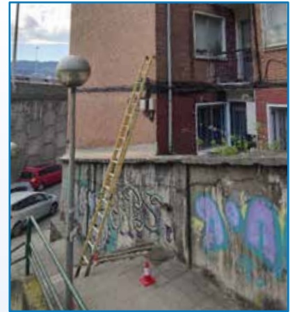
Antes de facer uso da escada, comproba que tanto os chanzos como o calzado están limpos, libres de graxa, aceite ou calquera outra substancia deslizante.
