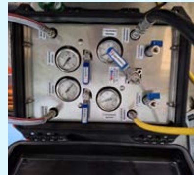
Cadro de distribución de gases
