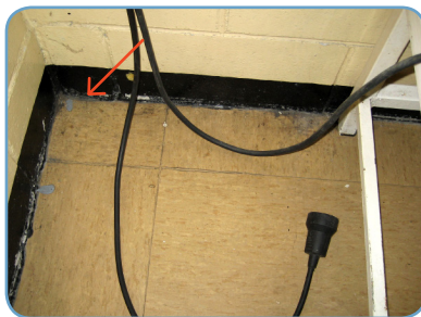
Masilla selando bordos
