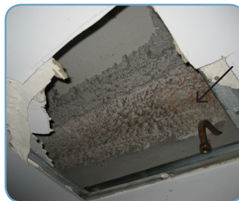
Proxectado sobre viga metálica
