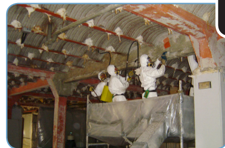
Retirada manual de morteiro de amianto 1
