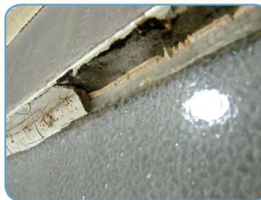
Masilla selante en unión (ventá)
