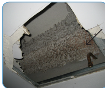
Projectado sobre viga metálica
