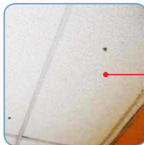
Paneles de falso techo
