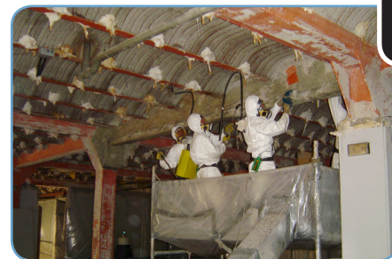
Retirada manual de mortero de amianto 1
