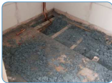
Relleno en el piso (bajo entarimado)
