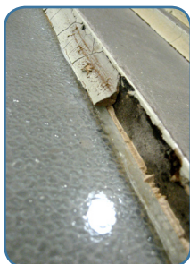
Masilla selante en unión (ventá)
