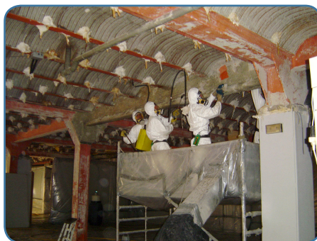
Retirada manual de morteiro de amianto 2
