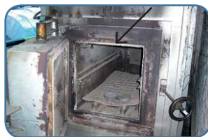
Cordón de amianto que sela a porta 2
