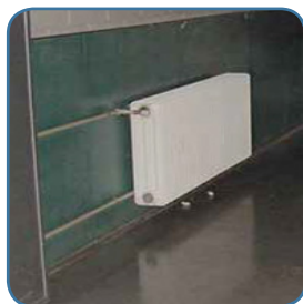
En pavimento e zócalo 1
