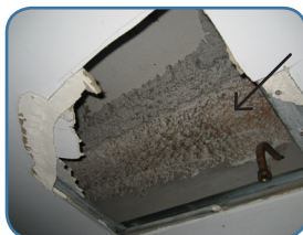
Proxectado sobre viga metálica
