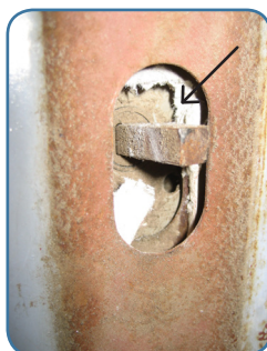
Interior de puerta cortafuegos
