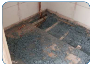
Relleno en el piso (bajo entarimado)
