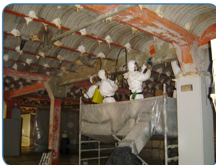
Retirada manual de mortero de amianto 2
