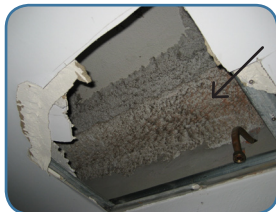
Proyectado sobre viga metálica
