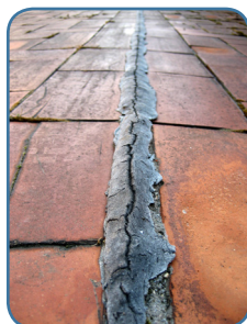
Masilla en junta de dilatación
