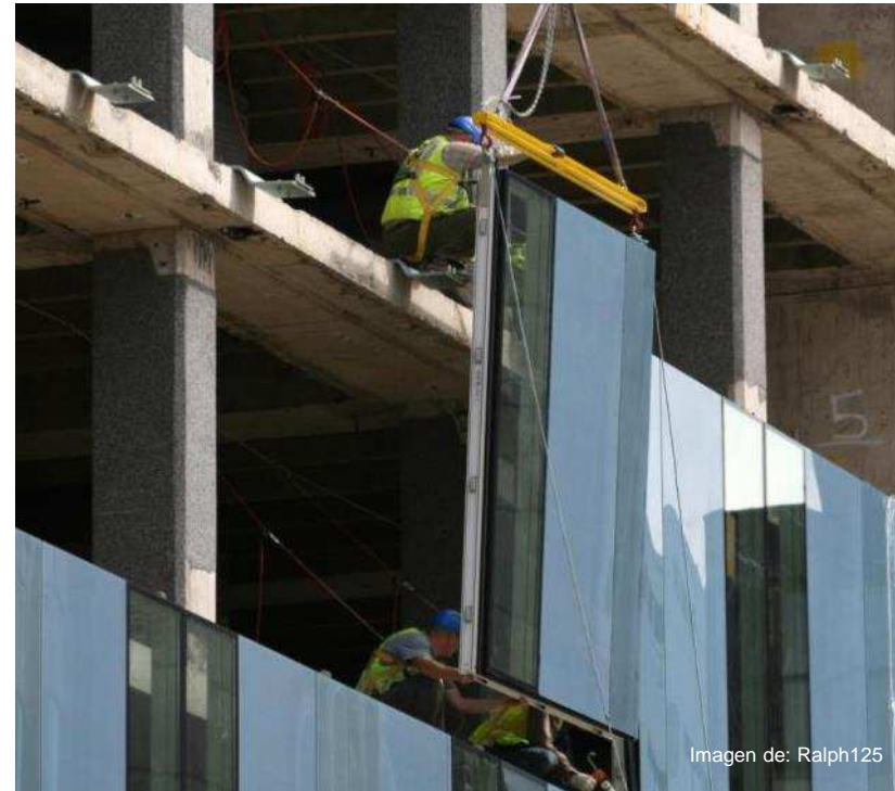
Colocación de fachada
